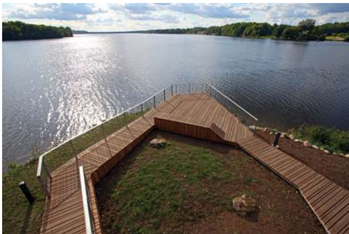
Puidust vaateplatvorm Lätis
